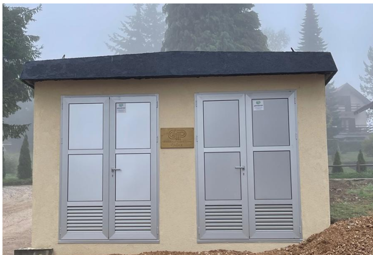
Slika br. 9. Primjer građevinskog objekta trafostanice
